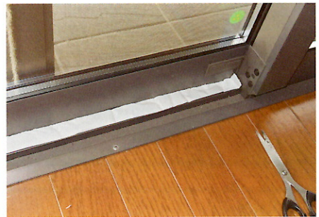
隙間シートで目張り
