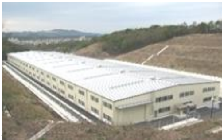
管理型（クローズド型）最終処分場
