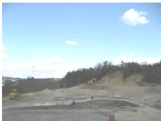
安定型最終処分場
