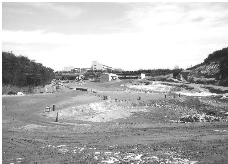
安定型最終処分場
