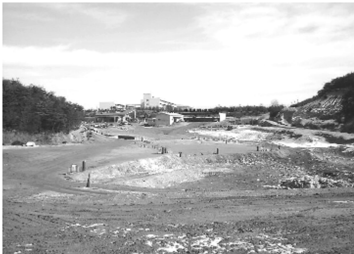
安定型最終処分場
