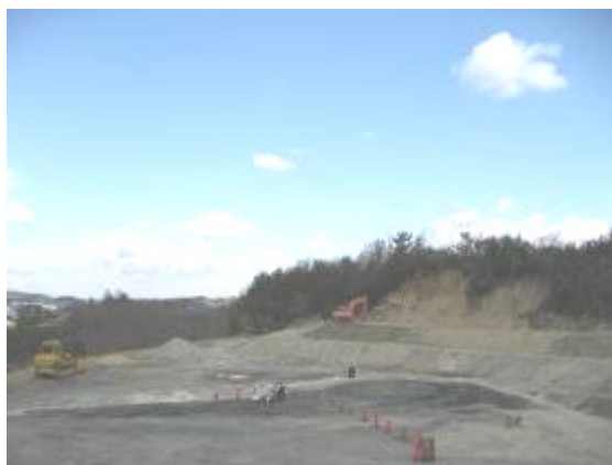
安定型最終処分場
