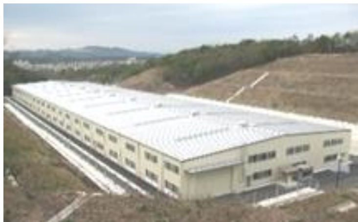
管理型（クローズド型）最終処分場
