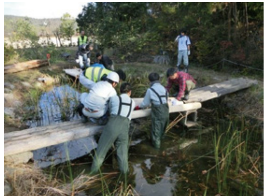
図 2-3-11：市内ビオトープ修繕の様子（写真）
