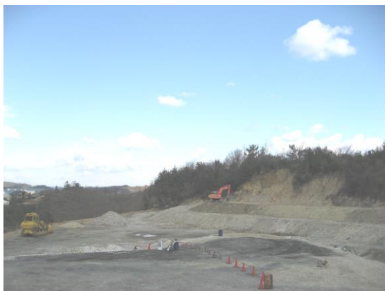
安定型最終処分場
