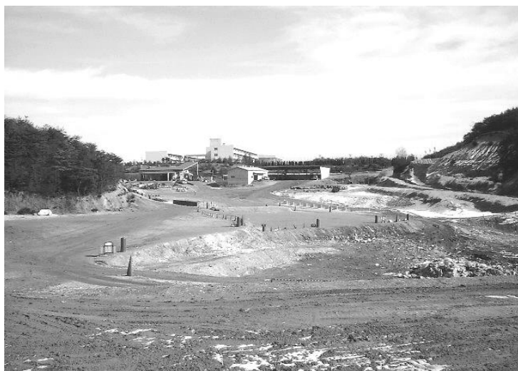
安定型最終処分場
