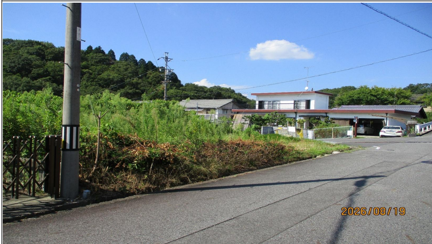
公売財産（南西より）
